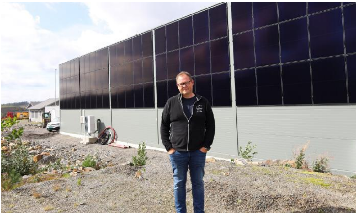
Frode Bjønnes har på rekordtid etablert et av landets mest fremtidsrettede ladeanlegg for tunge kjøretøy. Med en kombinasjon av solceller, batteribank og kraftige hurtigladere skal anlegget både kutte strømprisen og gjøre det enklere å velge grønn transport. Foto: Elisabeth Nodland
